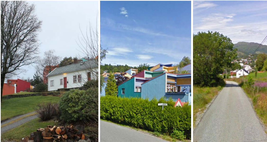
Figur 37. Kulturmiljøet på Rolland. Gårdshus fra 1800-tallet inne i boligområdet Selegrend, deler av bygningsmassen i Selegrend (fra Google map), gårdsbebyggelse på Øvre Rolland
