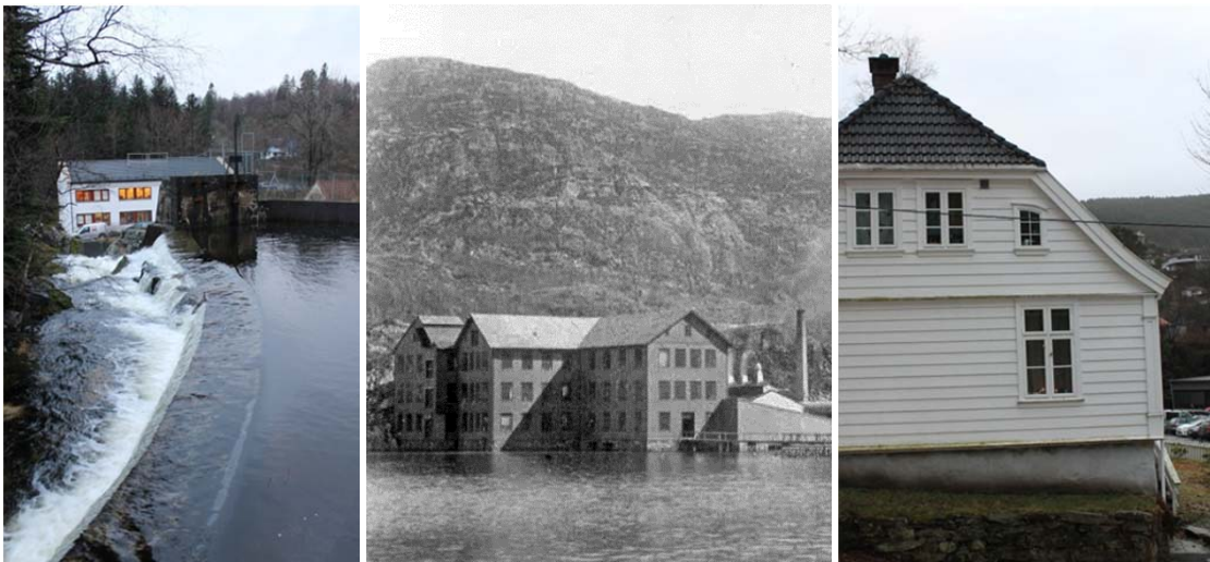
Figur 32. Eidsvåg Fabrikker. Fra venstre til høyre: demning med vanninntak ovenfor fabrikkområdet, Eidsvåg Fabrikker i 1896 (Fyllingsnes 2007, s. 31) og Gamle Eidsvåg gård
